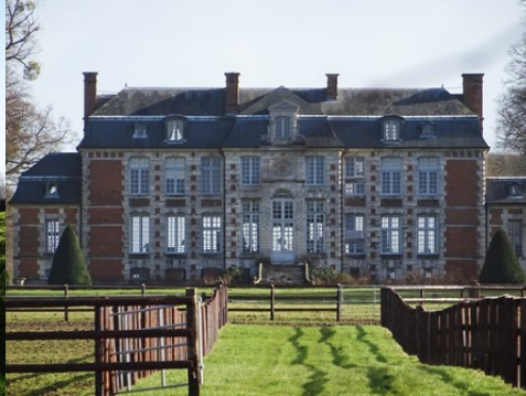
La façade nord (vue éloignée)
