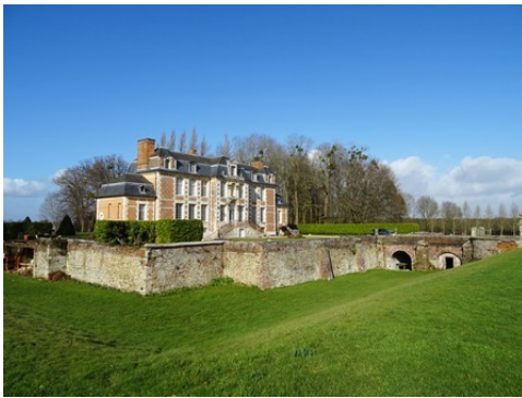
Le château et ses fossés vu du Sud
