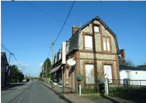
Une maison mêlant briques et moellons
